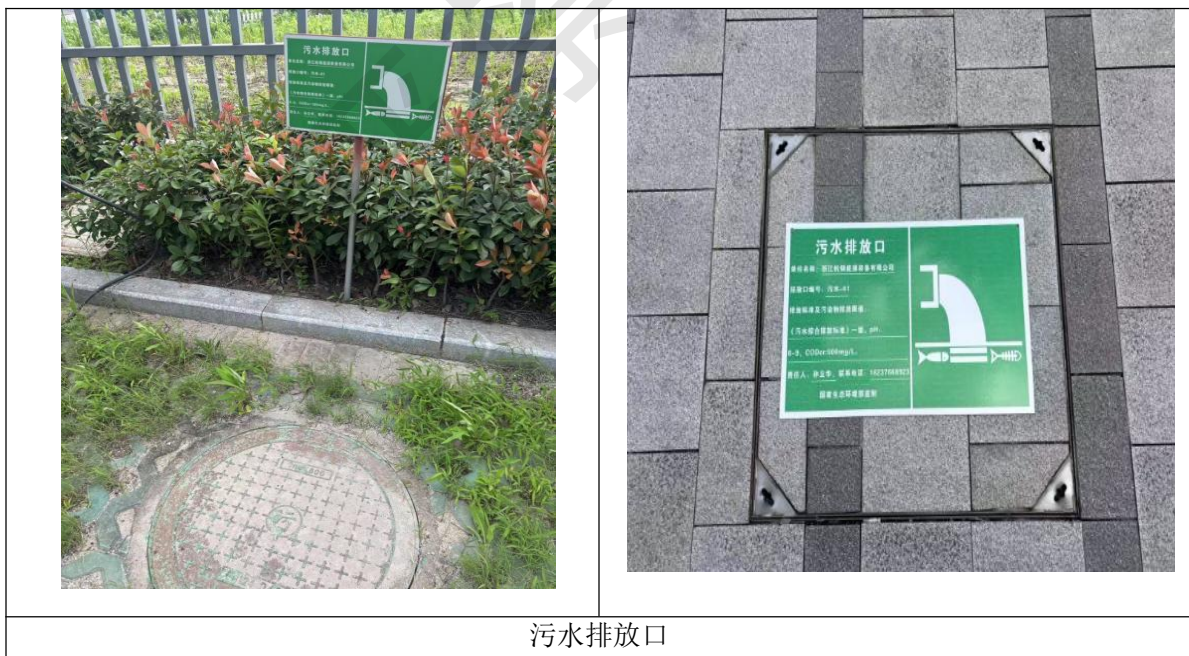
图 3-4 污水排放口现场图
