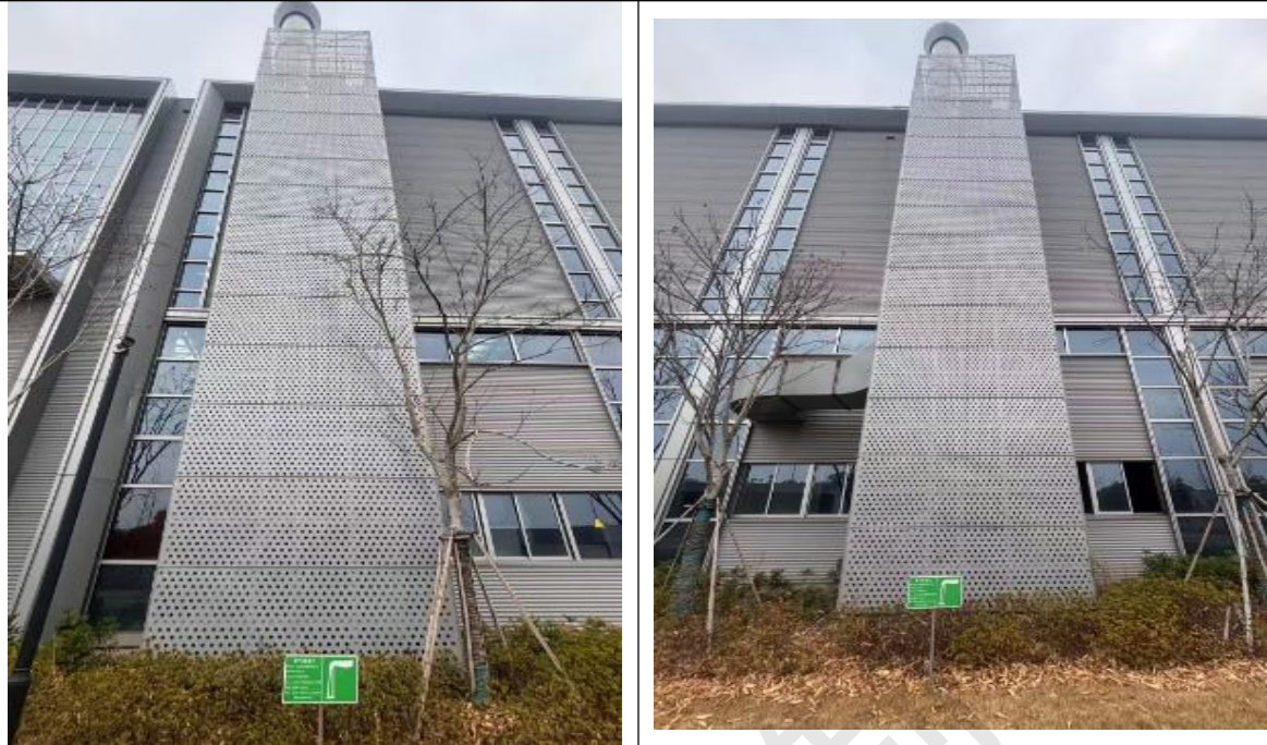
排气筒及标识标牌
